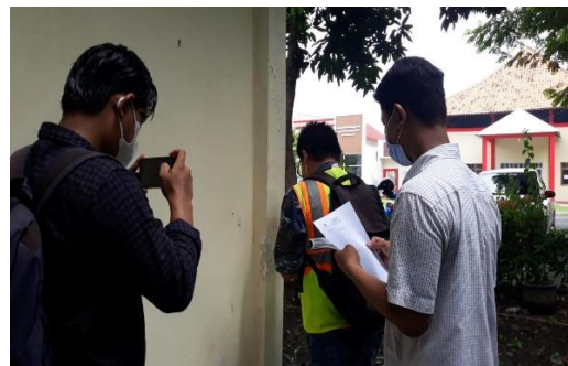
Gambar 2. Uji kekuatan beton dengan Hammer Test
