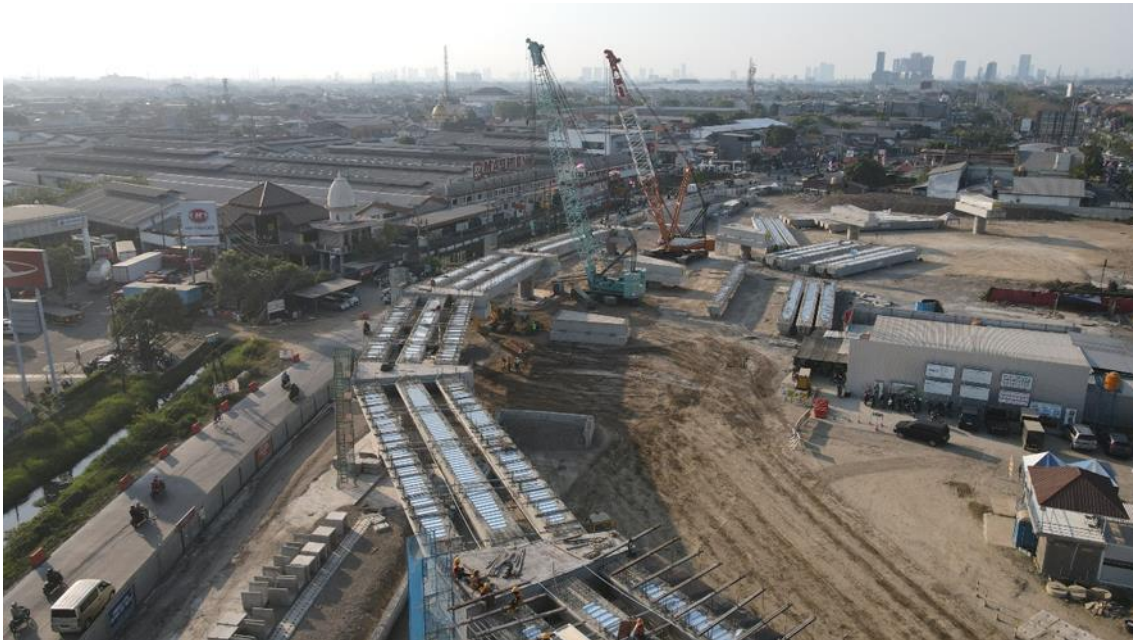
Gambar 9. Proses Erection PCU Girder FO Djuanda Sumber : (Dokumentasi Proyek FO Djuanda, 2024)
