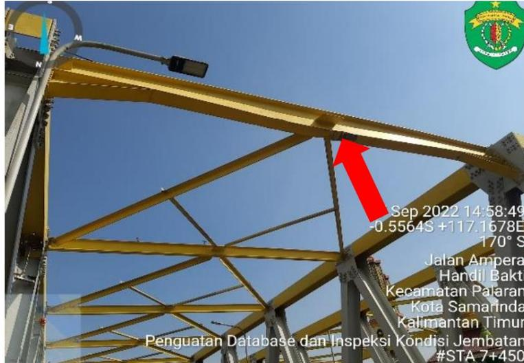
**Gambar 3.** Terlihat penyok pada rangka Jembatan
