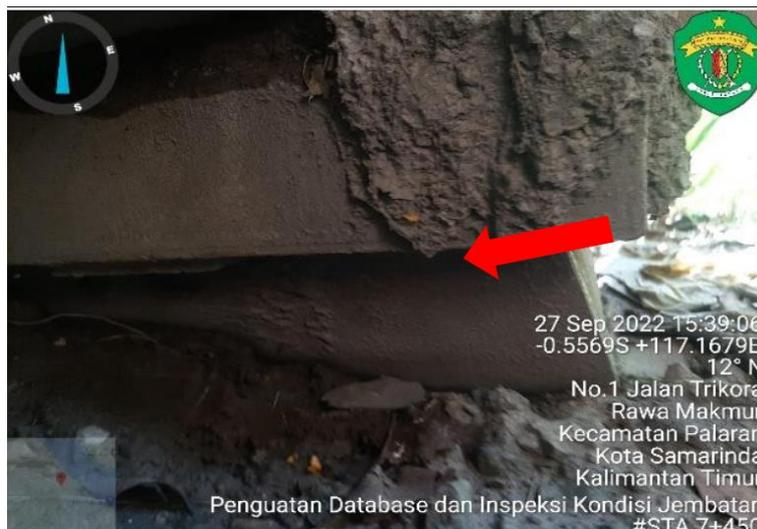
**Gambar 7.** Terlihat Elastomer mengaaaalami kerusakan
