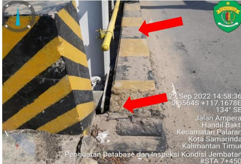
**Gambar 5.** Terlihat trotoar spaling dan aus
