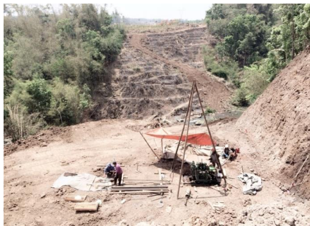
Gambar 3. Lokasi Pengujian SPT di P1
