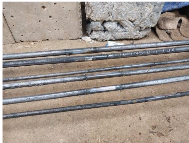
Gambar 6. Tulangan yang telah dibersihkan.
