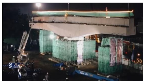
Gambar 6. Pemutaran Pierhead Metode Sosrobahu
