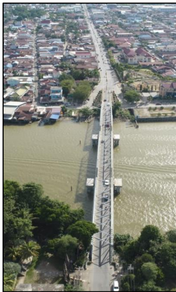
a. Tampak Atas Jembatan
