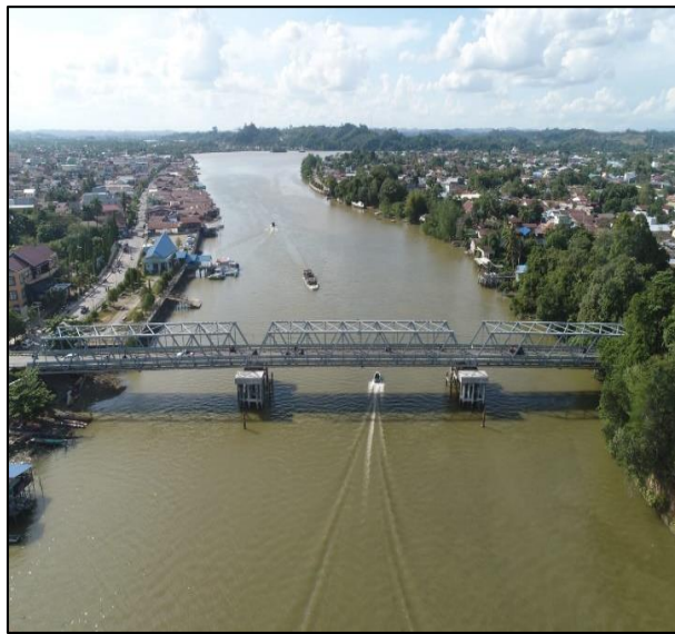
b. Tampak Samping Sisi Hulu Jembatan
