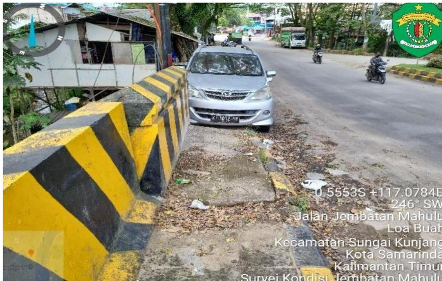
**Gambar 5.** Terlihat trotoar spaling dan aus
