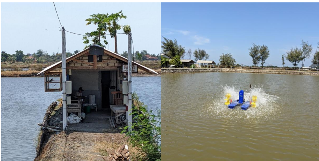
Gambar 4. Elektrifikasi Tambak dan Kincir
