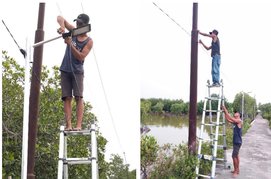
Gambar 6. Pemasangan instalasi lampu jalan sepanjang jalan penghubung antar desa
