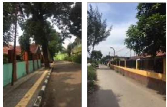
Gambar 3. (a) Sekolah terlayani trotoar (b) Sekolah tidak terlayani trotoar
