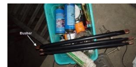
Gambar 2. Pembersihan Kubikel dan kontak busbar
