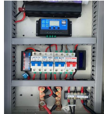
Gambar 3. Rangkaian PLTS pada panel box
