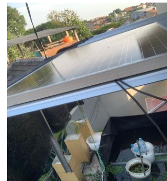
Gambar 4. Hasil Pemasangan Panel surya
