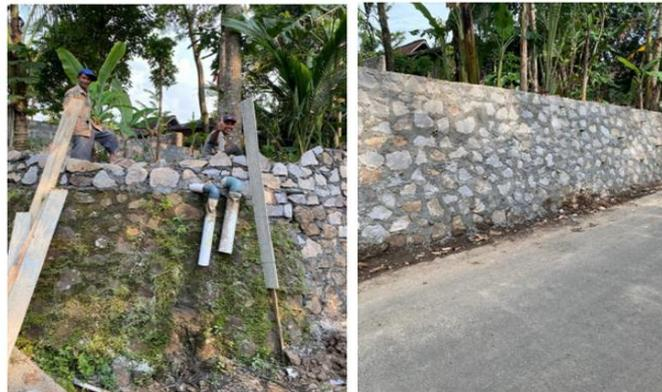
**Gambar 5.** Hasil Akhir Pekerjaan Pembangunan Turap Tebing
