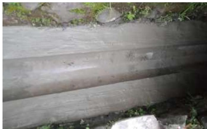
**Gambar 3.** Hasil Perbaikan Saluran Air
