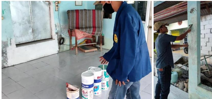
**Gambar 1.** Proses Persiapan Pengecatan dan Pengikisan Cat Lama
