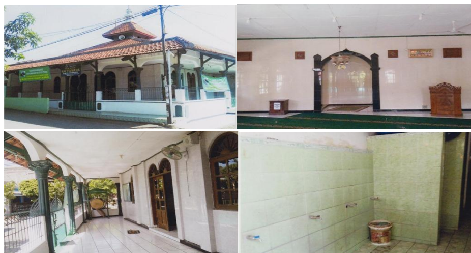
Gambar 1. Kondisi Eksisting Masjid As-Syuhada
