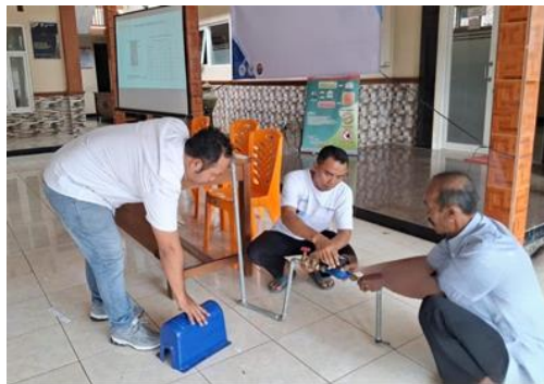
Gambar 4. Perakitan Pipa Besi
