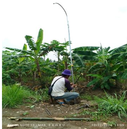
Gambar 3. Pemasangan Tiang Lampu
