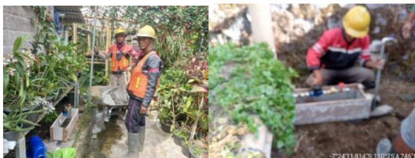
Gambar 3. Pemasangan Sambungan Rumah
