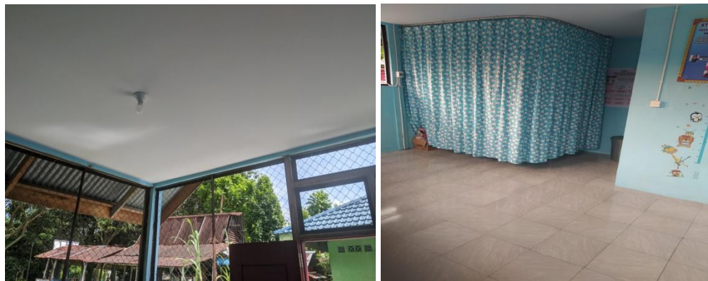
Gambar 3. Pemasangan Plafond dan Tirai Pembatas
