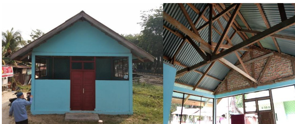
Gambar 1. Kondisi Eksisting Posyandu Mekar Kuntum Bau Semerbak
