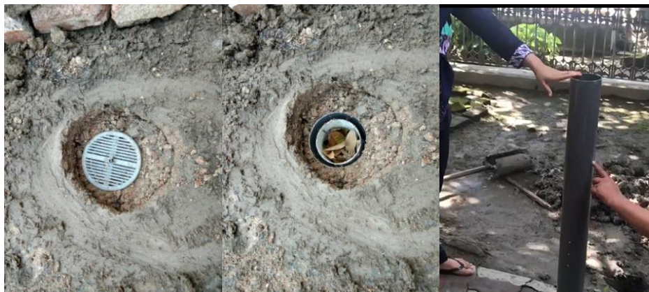
Gambar 4. Pemasangan LRB di Halaman Rumah Warga ke I
