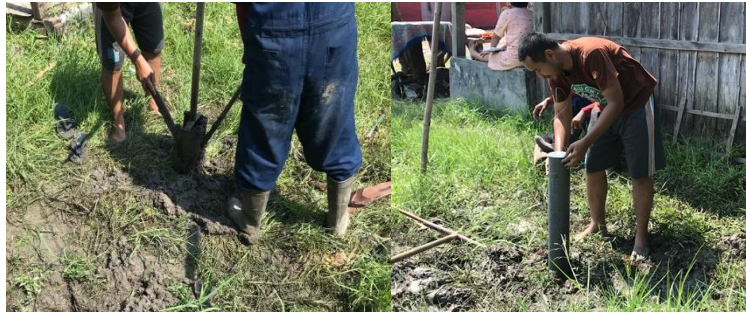
Gambar 6. Pemasangan LRB di Halaman Rumah Warga ke II
