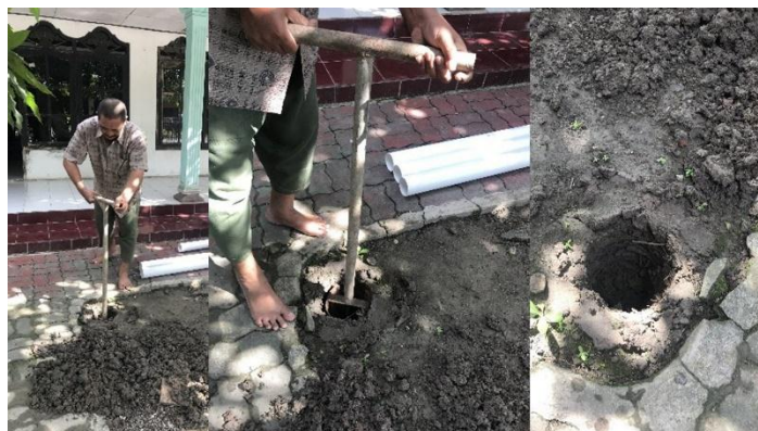
Gambar 3. Penggalian Tanah untuk LRB di Halaman Rumah Warga ke I
