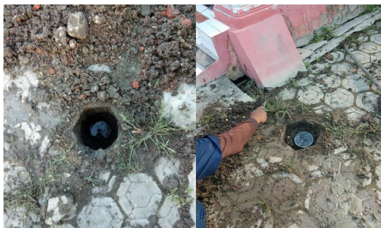
Gambar 10. Pemasangan LRB di Halaman Rumah Warga ke IV
