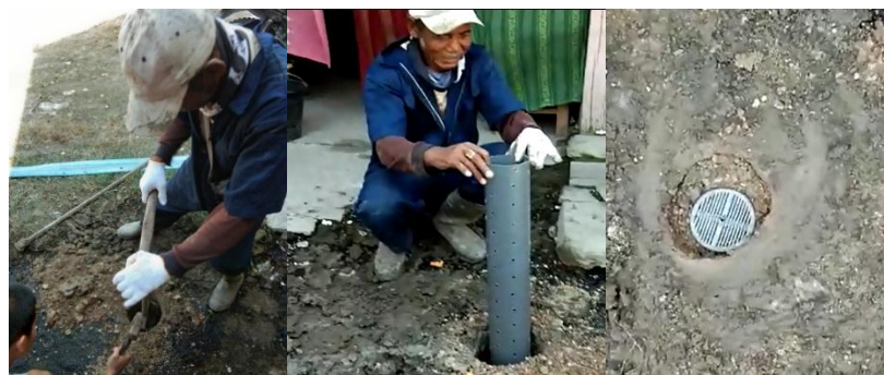
Gambar 8. Pemasangan LRB di Halaman Rumah Warga ke III
